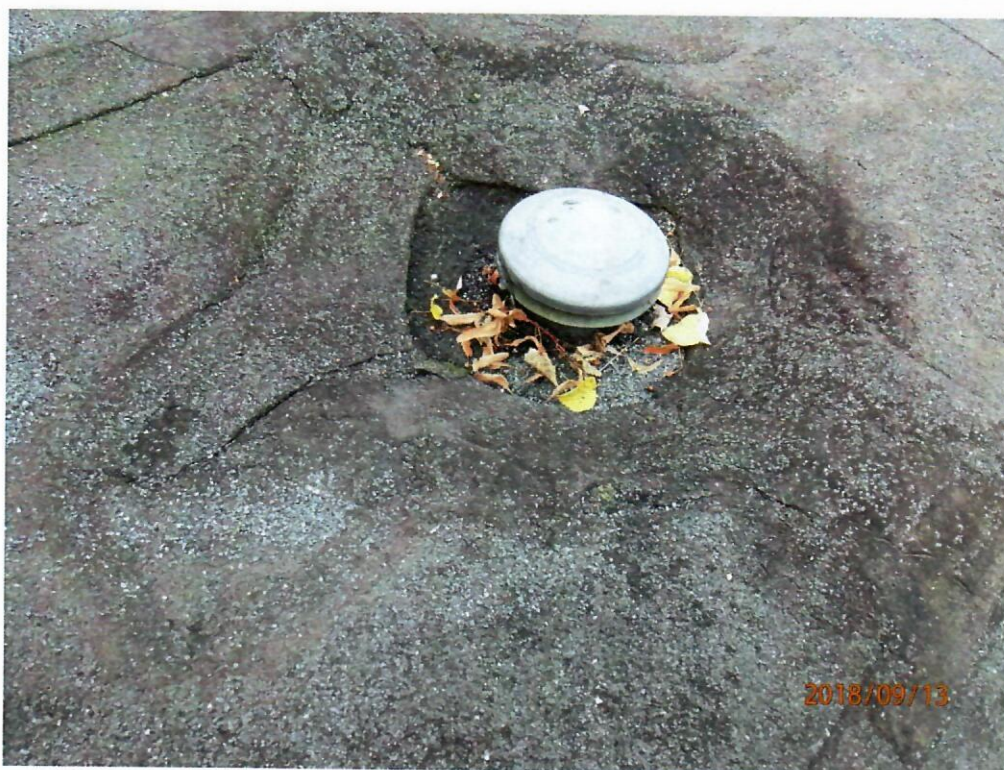
Fot. 37. Zaleganie liści i posypki łupkowej z papy może doprowadzić do zapchania odpływu wód opadowych
