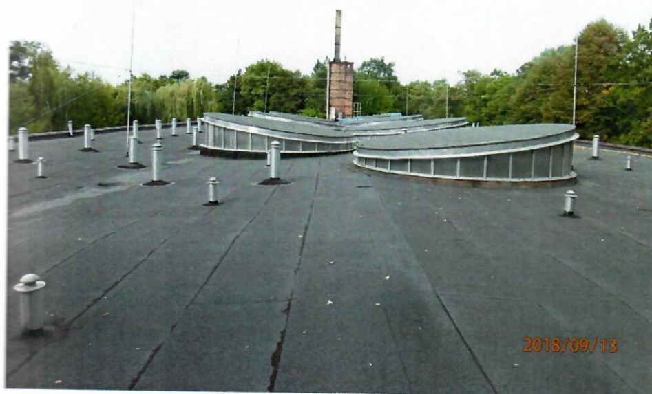
Fot. 1. Ogólny widok dachu pawilonu dydaktycznego. Zdjęcie wykonano z kierunku wschodniego. Widoczne liczne wywietrzniki przechodzące przez dach stanowią potencjalne źródło przecieków.
