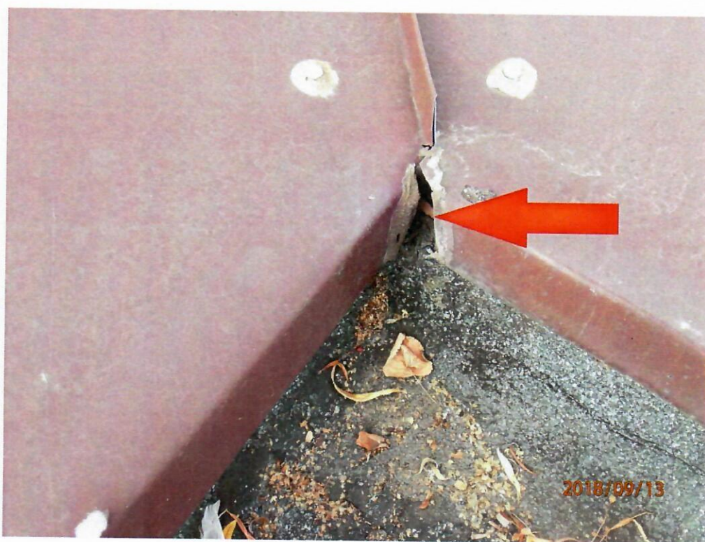
Fot. 35. Źle wykonane połączenia obu płaszczyzn obróbki attyki
